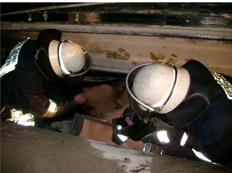
Da eine Abdichtung der Hydraulikleitung nicht möglich war, wurde das weiter auslaufende Öl mit einer Wanne aufgefangen. Weitere Maßnahmen waren nicht erforderlich.
