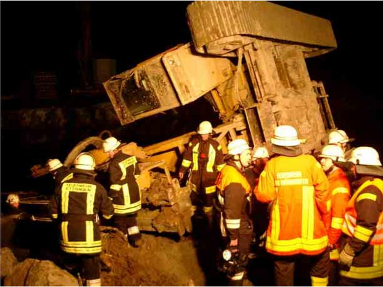
Auf einer Baustelle an der Wertach, an der eine neue Brücke für die Ortsumgehung von Ettringen entsteht, stürzte ein 80 Tonnen schweres Bohrgerät auf der nachgebenden Uferböschung um, wobei der Ausleger zum größten Teil in der Wertach versank. Die Freiw. Feuerwehr Bad Wörishofen wurde gemeinsam mit der FF Ettringen nach Alarmstufe 7 (Gefahrgutunfall) an die Unfallstelle alarmiert.
