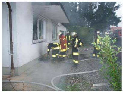
Durch einen Lichtschacht konnte von Außen der Feuerschein in der Waschküche gesehen werden. Nachdem die Einbruchssicherung an der Lichtschachtabdeckung abgeflext war, wurde das offene Feuer über den Lichtschacht mit einem C-Rohr abgelöscht.
