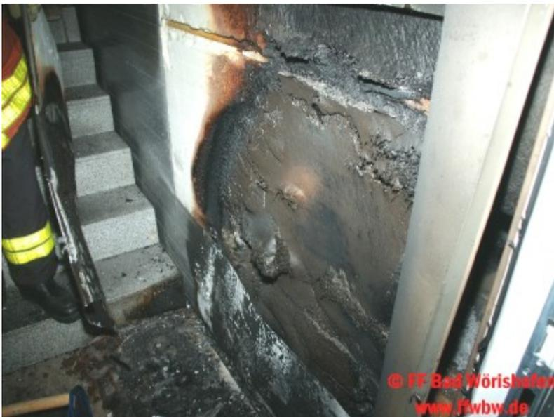
Mit der Adamant Rettungssäge wurde am Brandort die Wandverkleidung entfernt, um die darunter liegende Isolierung kontrollieren zu können. Hier kam auch die Wärmebildkamera zum Einsatz.
