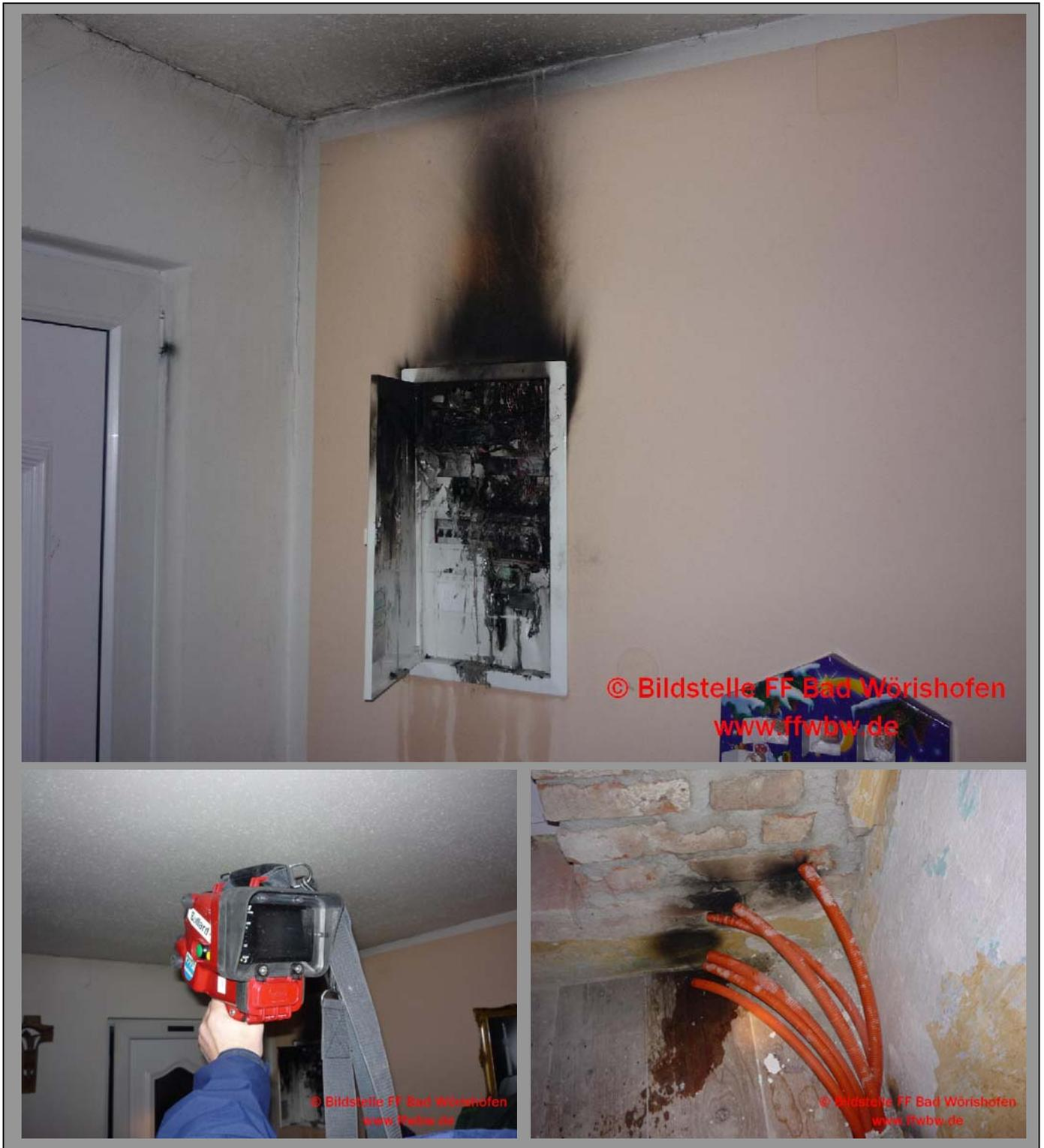
Nach dem Brand in einem Sicherungskasten in einem Wohnhaus in Irsingen wurde die Freiw. Feuerwehr Bad Wörishofen von der Polizei gerufen, um die Brandstelle mit einer Wärmebildkamera zu kontrollieren. Der Brand selbst war von den Bewohnern gelöscht worden. Mit Hilfe von zwei Wärmebildkameras wurde die Wand und die alte Holzbalkendecke mit Leerrohrdurchbrüchen auf versteckte Glutnester untersucht. Es wurden jedoch keine außergewöhnlichen Wärmebelastungen festgestellt.
